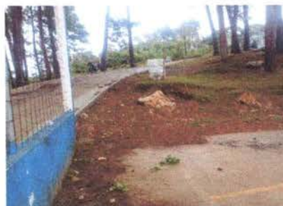
Foto 6: Construcción del Portón Principal
