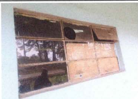
Foto 5: Cambio de ventana aula 3, aula 4
