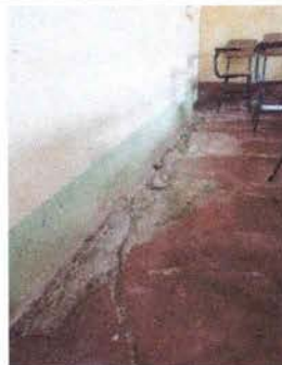
Foto 2: Colocación de piso cerámico Aula 3.
