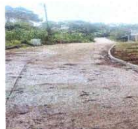
Foto 2: Construcción del Segundo portón.
