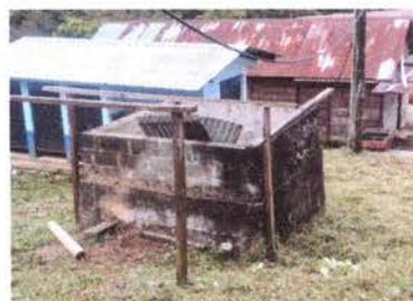
Foto 4: Reparación de depósito de agua
