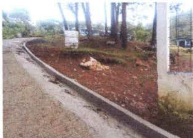
Foto 1: Construcción de cerco o muro perimetral.
